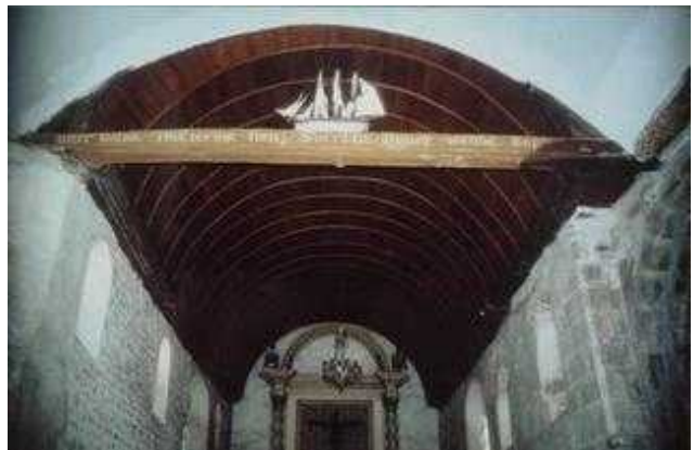
Eglise de Saint-Jean-le-Thomas. Le chœur pré-roman (intérieur). Sa voûte en berceau de bois fut ajoutée en 1965 et terminée en 1973. [050]
