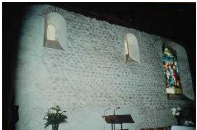
Eglise de Saint-Jean-le-Thomas. Le chœur pré-roman (intérieur) et son mur latéral nord. L'appareil de granit des murs et les claveaux de briques des baies sont également visibles à l'intérieur, suite à la restauration du chœur en 1965 sous la direction d'Yves-Marie Froideveaux, architecte en chef des monuments historiques. Les cinq petites baies aux claveaux de briques (trois au nord et deux au sud) furent retrouvées et réouvertes à cette date. [048]
