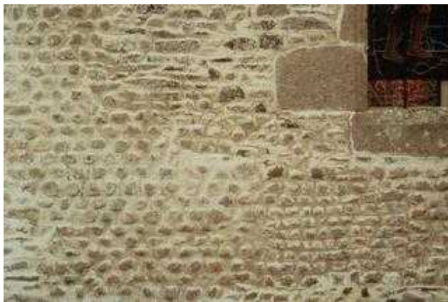
Eglise de Saint-Jean-le-Thomas. Le chœur pré-roman et son mur latéral nord. Détail de l'appareil de petits blocs de granit assez réguliers pris dans d'épais joints de mortier. Près de la baie ouverte en 1895, des maçonneries plus récentes sont faites de moellons de schiste et de granit, matériaux locaux. [047]
