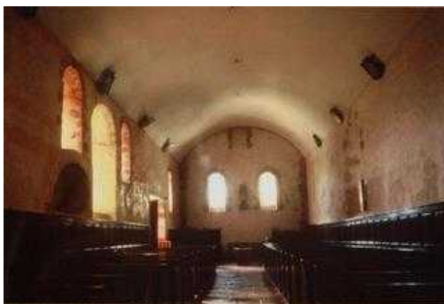
Eglise de Saint-Jean-le-Thomas. La nef romane (intérieur). Construite au 11e siècle, la nef fut terminée au début du 12e siècle. Sa voûte en berceau est en plâtre. Le sol est recouvert de larges dalles de granit. Dans le mur occidental (situé au fond), les deux baies romanes ont été réouvertes en 1964, après avoir été retrouvées sous l'enduit. La baie supérieure - une baie médiane située dans le mur pignon - fut murée à la même date. Ses piédroits de granit restent toujours bien visibles. [051]
