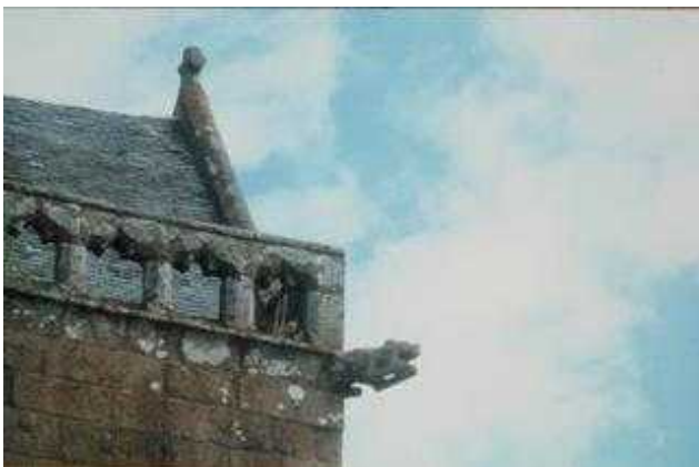
Eglise de Genêts. La partie supérieure de la tour. La tour est surmontée d'un toit en bâtière dont le départ est caché au nord et au sud par une balustrade ajourée. Les angles de la balustrade sont ornés de gargouilles gothiques en forme de chiens, loups et animaux fantastiques. [075]
