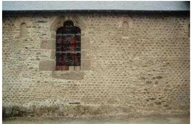
Eglise de Saint-Jean-le-Thomas. Le chœur pré-roman et son mur latéral nord. Haut situées, les trois petites baies en plein-cintre sont surmontées de claveaux de briques. La grande baie en plein-cintre à l'arcade trilobée fut ouverte en 1895. [046]
