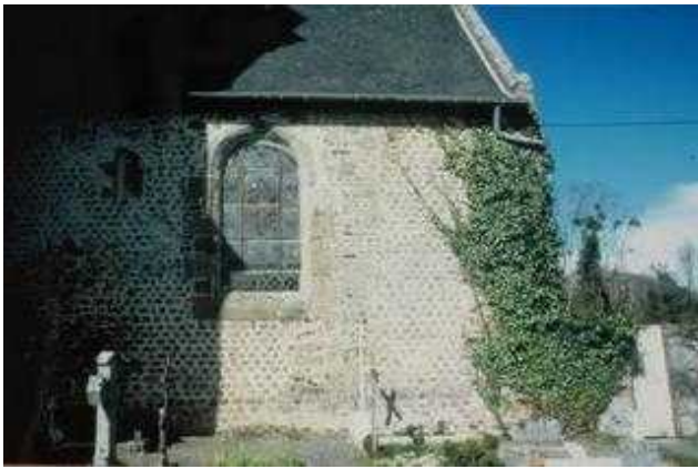
Eglise de Saint-Jean-le-Thomas. Le chœur pré-roman et son mur latéral sud. Ce mur est fait de moellons de granit pris dans un épais mortier. La petite baie en plein-cintre est romane. La grande baie fut percée en 1895, au moment de la reconstruction de la tour. [045]
